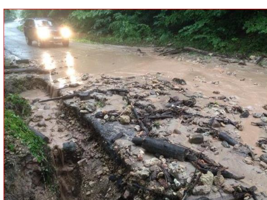
13.attēls Ceļa bojājumi Siguldā (3.)
